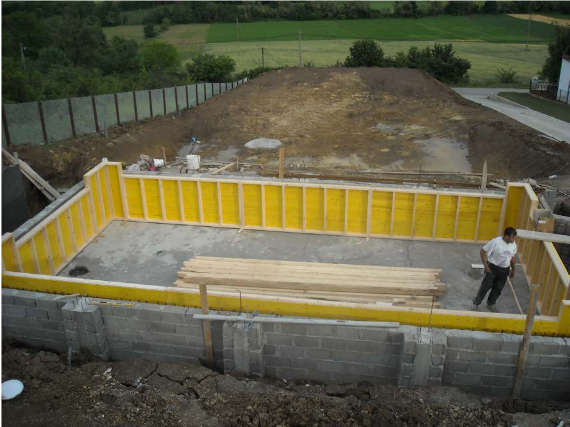
2. polaganje oplate s ugradnjom elemenata
