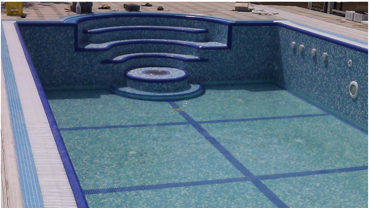
4, Mozaik pločice u betonskom bazenu
