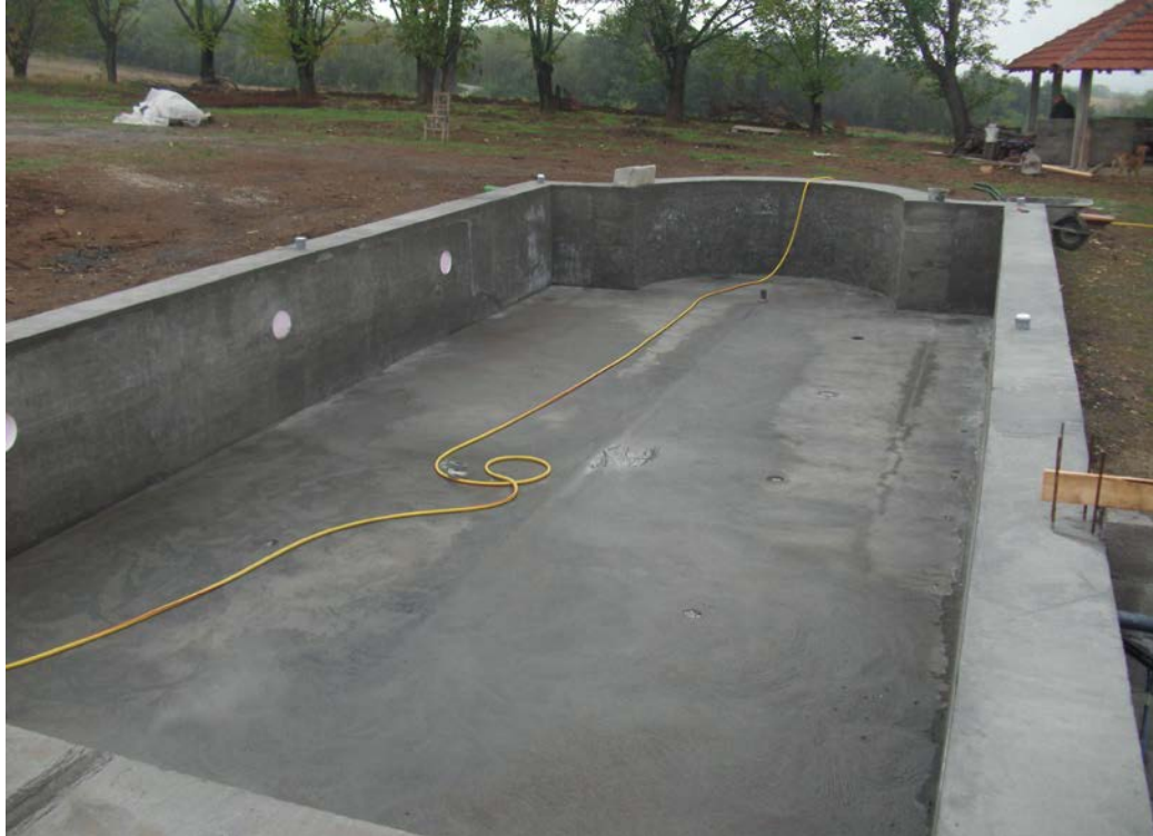
3. IZRAĐEN BETONSKI BAZEN SA STROJARNICOM PRE KONAČNE OBLOGE MOZAIKOM ILI OBLAGANJA POLIESTEROM
